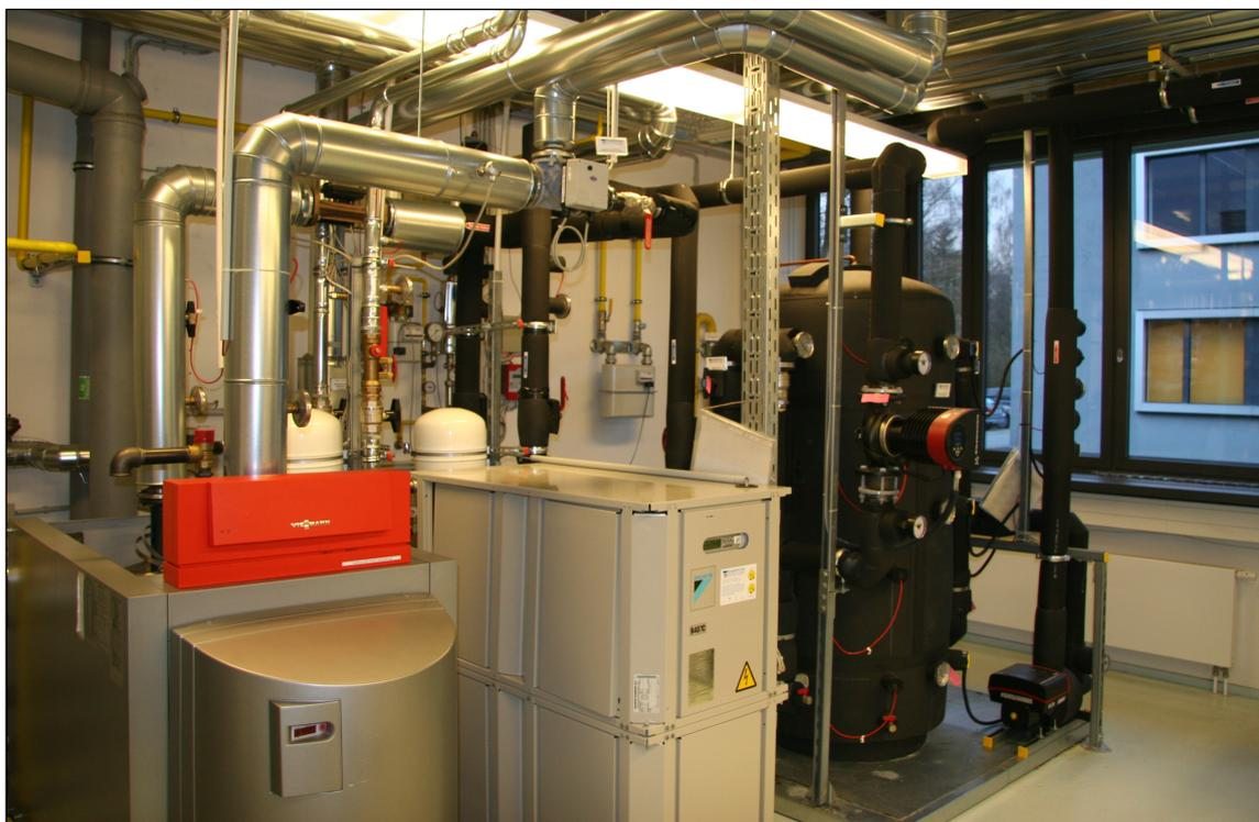
Abb. C- 3.6 Gebäudeseitige Hauptkomponenten der Versuchsanlage. **Links:** Gasbrennwertkessel. **Mitte:** Kompressionskältemaschine. **Rechts:** Thermischer Pufferspeicher. **Recht unten:** Umwälzpumpe.
